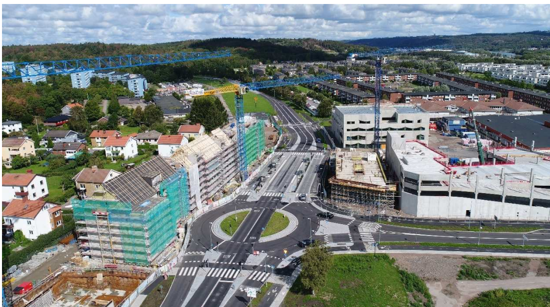
Vy från söder. Pågående ombyggnad kring Selma Lagerlöfs torg i förgrunden, direkt söder om planområdet.
